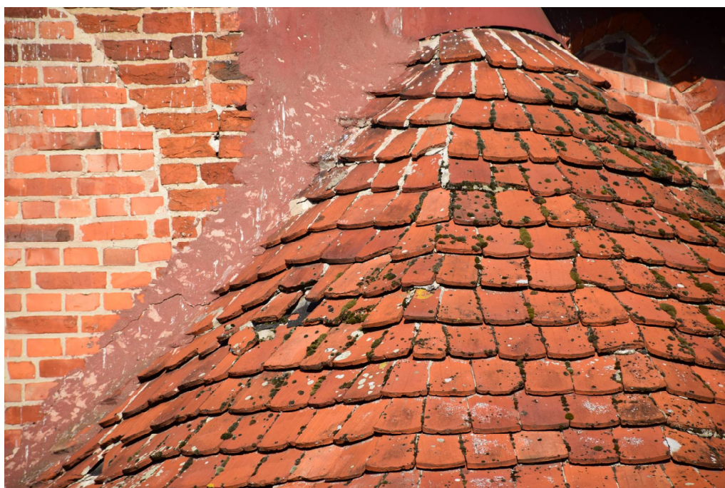
Ubytki i uszkodzenia w obrębie pokrycia dachowego
