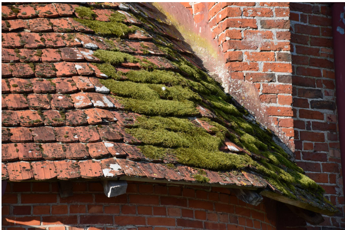
Naloty biologiczne w obrębie pokrycia dachowego
