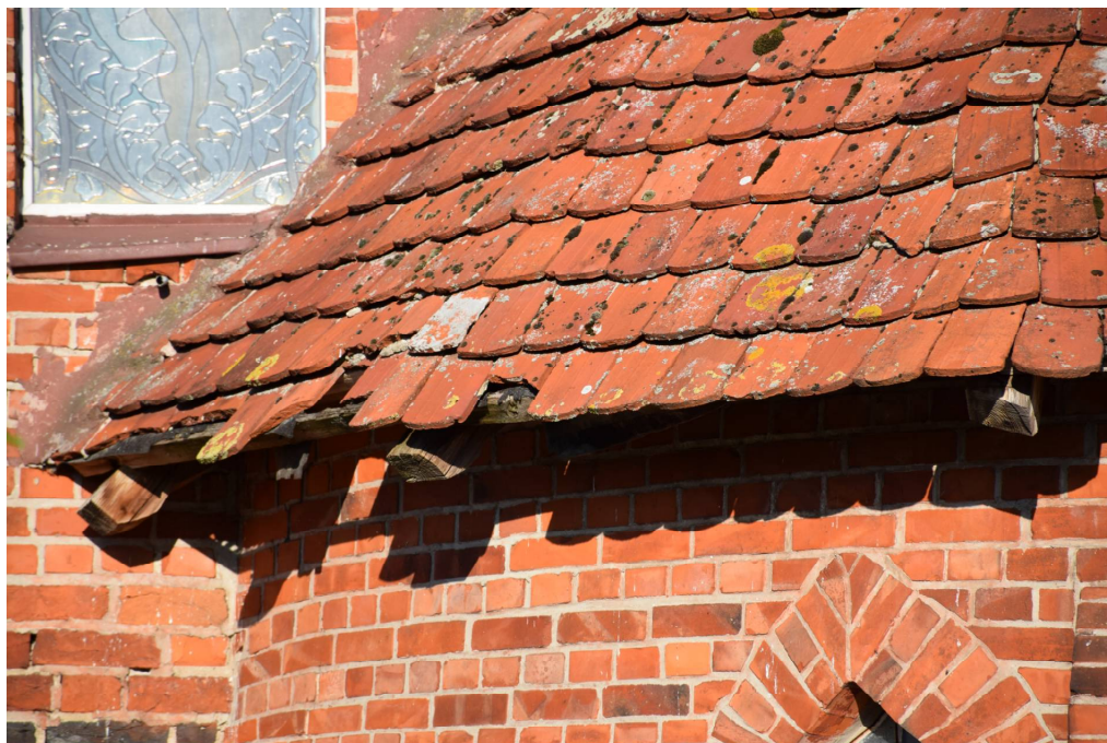
Ubytki i uszkodzenia w obrębie pokrycia dachowego, i okapu
